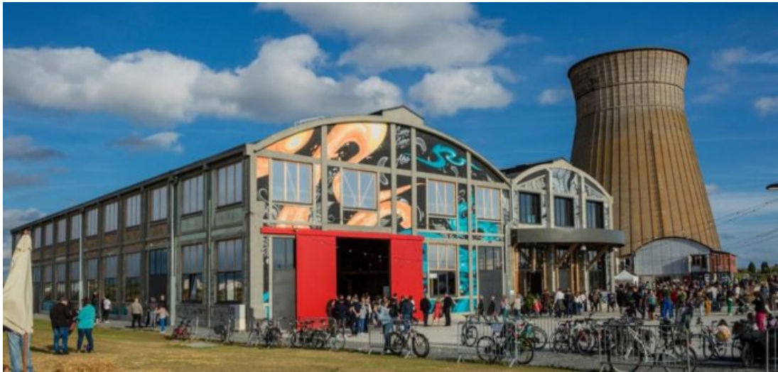
Le Wip installé dans l'ancienne usine SMN, à Colombelles près de Caen
